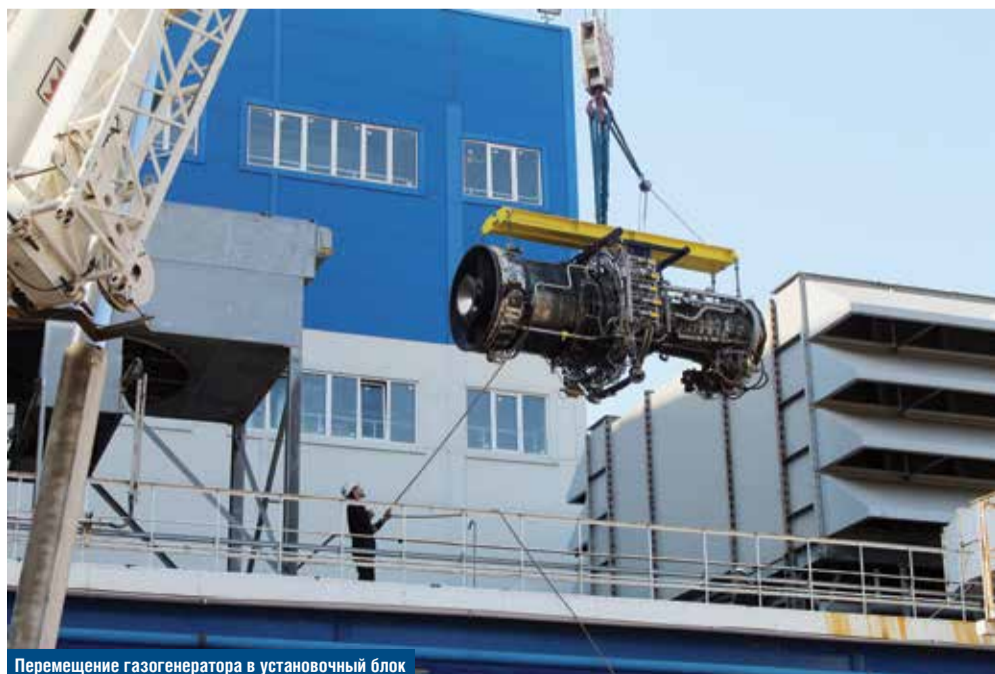
Перемещение газогенератора в установочный блок
