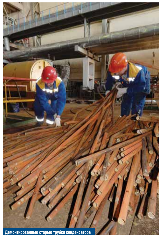
Демонтированные старые трубки конденсатора
