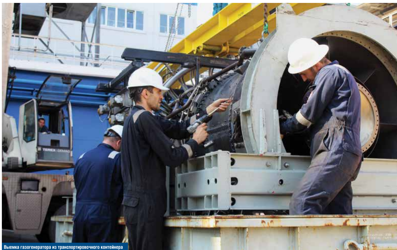
Выемка газогенератора из транспортировочного контейнера
