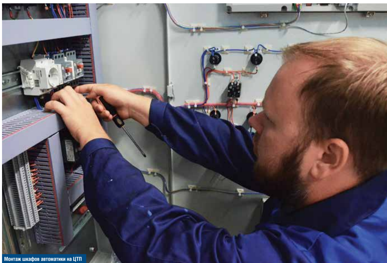
Монтаж шкафов автоматики на ЦТП
