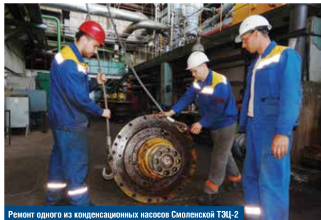
Ремонт одного из конденсационных насосов Смоленской ТЭЦ-2
